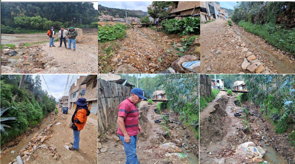
Imagen N°01.- Se observa en las fotografías, que la QUEBRADA PARIAPUQUIO, se encuentra colmatado en su cauce y se encuentra sin protección en sus márgenes, del sector SAMANACRUZ.
